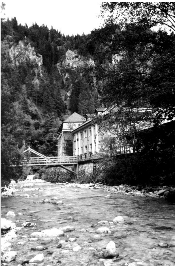
Das Kraftwerk Wienerbruck am Beginn des Ötschergrabens
