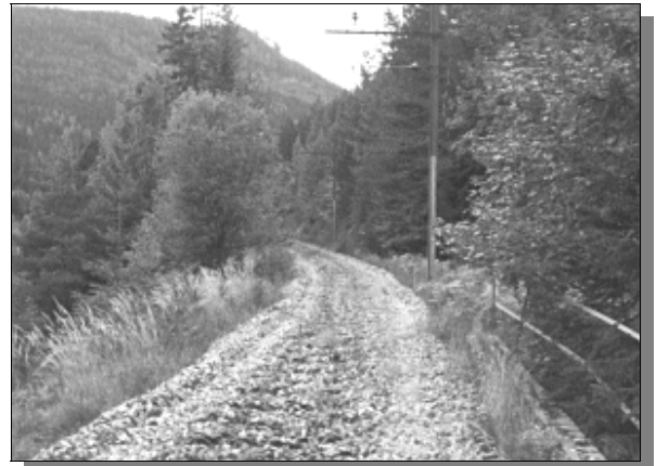
Demontage der Schienen und Schwellen zwischen km 85,2 und 86,0. Zwischen km 85,2 und 85,1 wurden die Schienen jeweils in Abständen von 10 - 12 m mit der Trennscheibe durchtrennt Text und Fotos von Wilhelm Schaller IG Pro Mariazellerbahn
