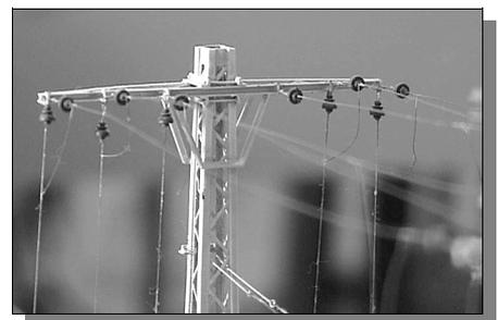
wesentlichen der Einheitsoberleitung der ÖBB, wenn man einmal davon absieht, dass auf der Normalspur Fahrdrabt und Tragseil getrennt abgespannt werden.
